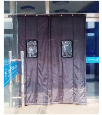
分厚い布製の防寒扉の例
