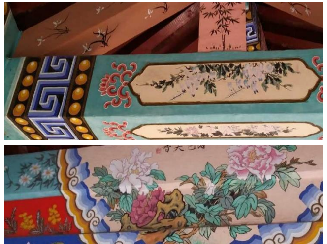
建物の天井[写真上]と梁の装飾[写真下](2016年9月撮影)
