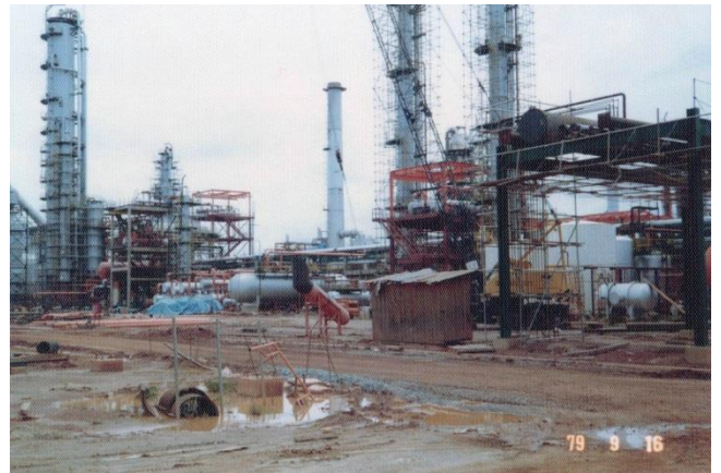
ぬかるみの中の現場
