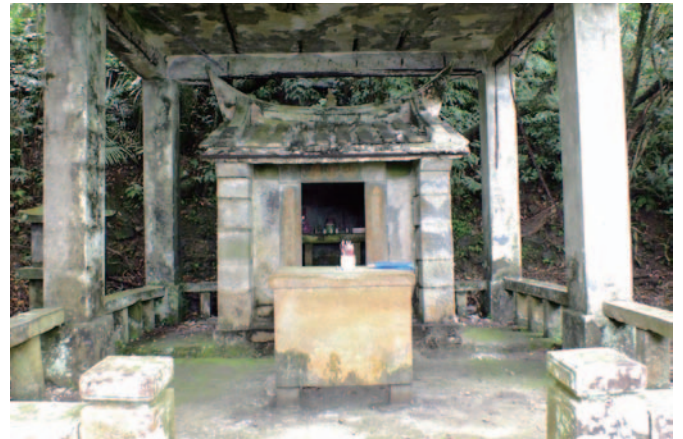
山神様のほくら、コンクリート製である
