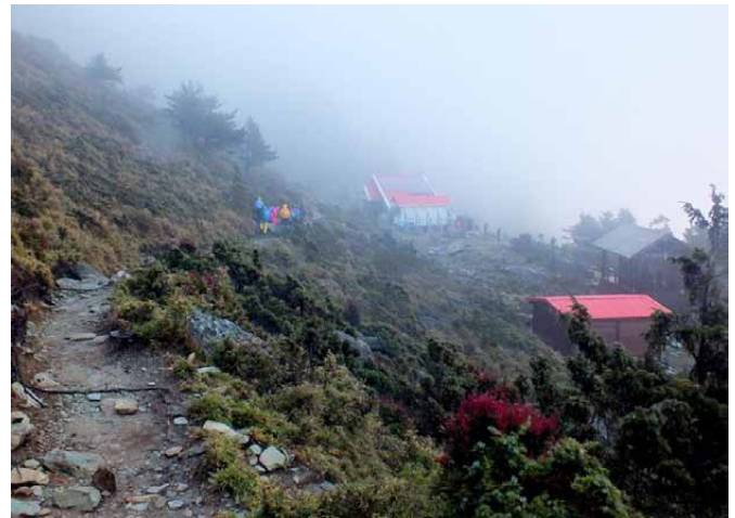
霧の中から現れた「嘉明湖避難小屋」。最奥の建物がそれ。
