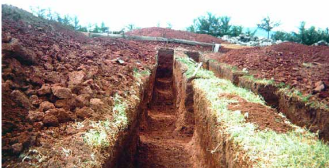
基礎工事の為に穴を掘る
