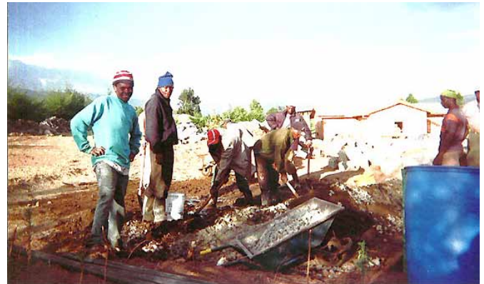
家を建てる基礎工事をする作業員たち
