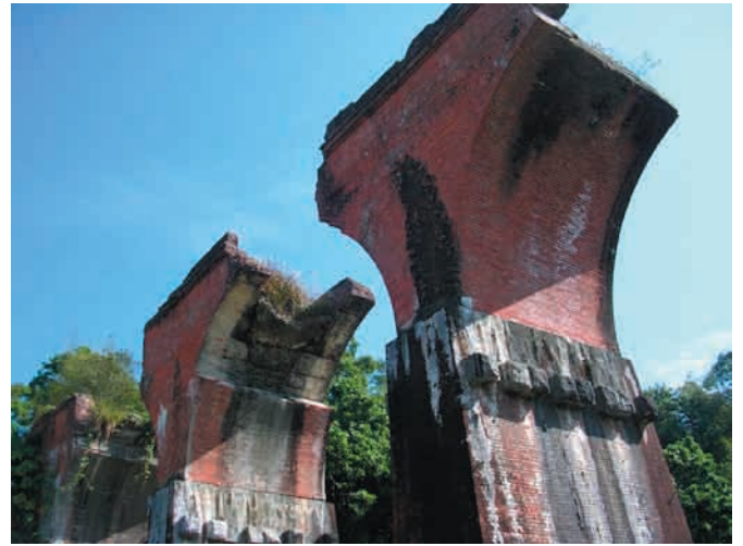
「龍騰断橋」、崩れ落ちた橋梁
