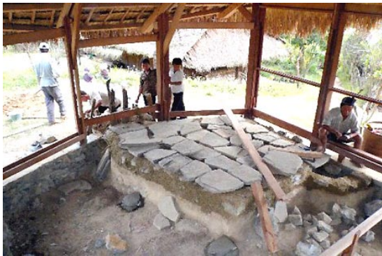
オンドル床のチームがかまどを作り、大工工事のチームが窓の枠を入れる。
