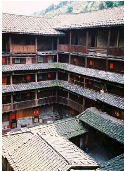
福建省和貴楼の内部。泥澤地にある方楼の5階建てで1つの階には28の部屋がある。中庭は狭い。
