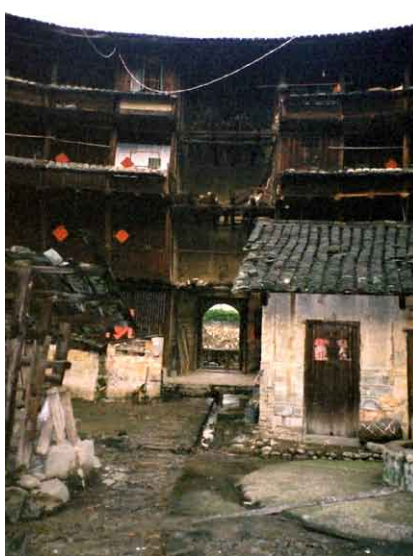
福建省環興楼内部。円楼4階建てで直径もかなり大きい住んでいる人は少なくがらんとしていた。内円の低い建物は以前の倉庫。
