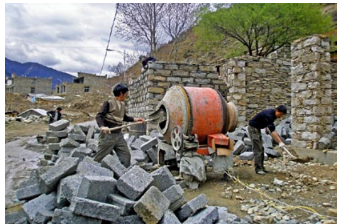
写真3 コンクリートブロックは日本で多く使われているものと違って空洞がありません。
