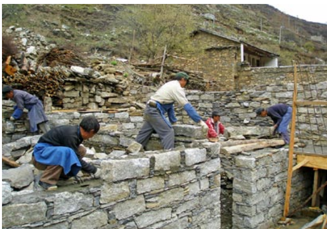
写真2 昨年の地震で壊れた教訓から今ではセメントで固めながら積む家がほとんどです
