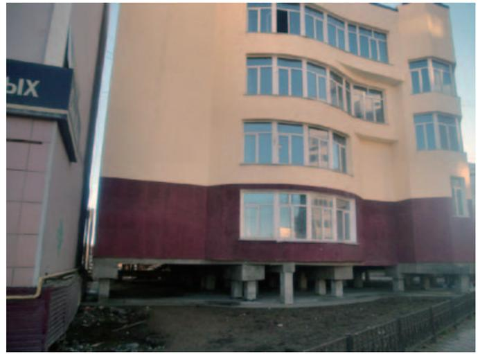
**高床式アパート** ヤクーツクの建物は大半が高床式です。永久凍土地帯なので、長い杭を打ち込んで、建物から出る熱で表層の氷が溶けないように「床を浮かせて」建てるのです。
