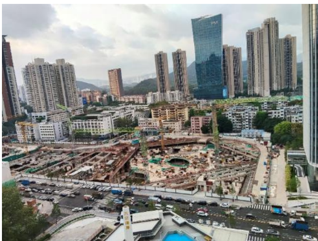
地下鉄工事現場(2026年4月撮影)
